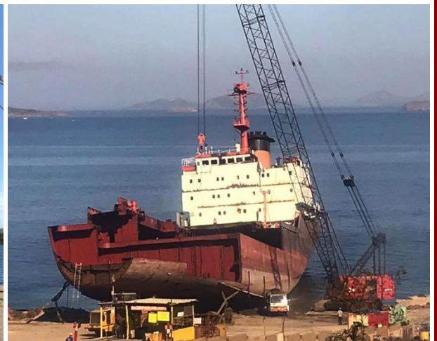
Démolition à Aliaga, août 2019. © Selim San
