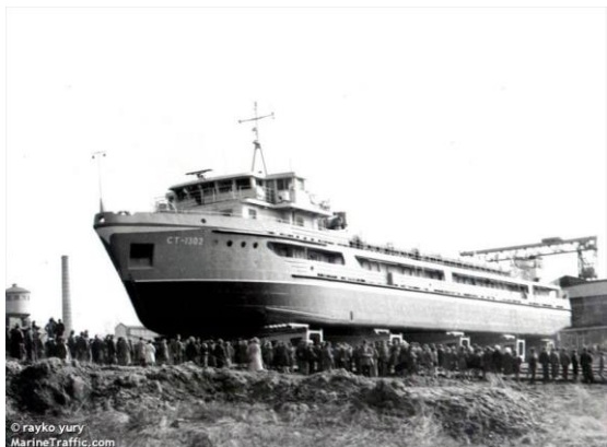
Construction du ST-1302. Collection Rayko Yury
