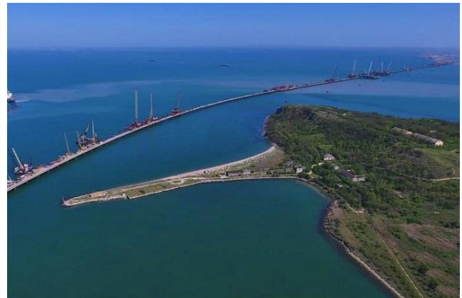
Construction du pont de Crimée
